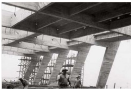
Pórticos de concreto armado do MAM em construção.
